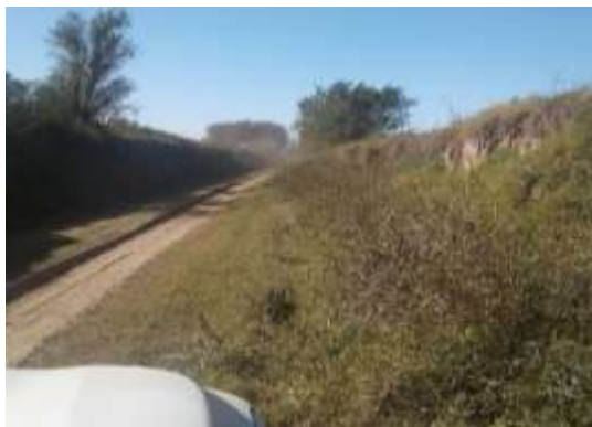
Figura 3: Imagen de camino con erosión de 2-3 m de profundidad en cuenca General Deheza.
