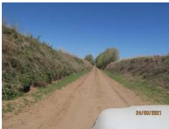
Figura 2: Imagen de camino con erosión de 2-3 m de profundidad en cuenca A. Suco
