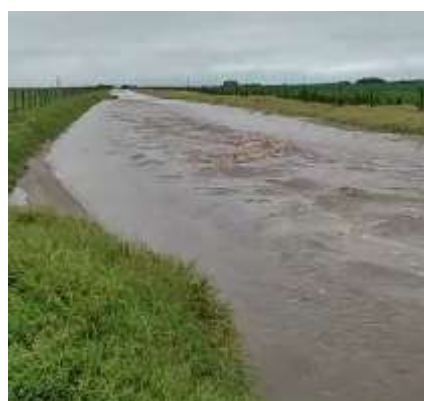
Figura 4: Caminos rurales mantenimiento y conectividad en el Suroeste de Córdoba. a. Remoción de traza y banquina con motoniveladora, b. Conducción de escorrentía por el camino.
