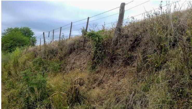
En la imagen siguiente notamos no sólo el descalce del poste con tendido eléctrico, sino la desaparición de alambrados, en ambos sentidos. Nótese que sólo quedó en pie un poste esquinero.
