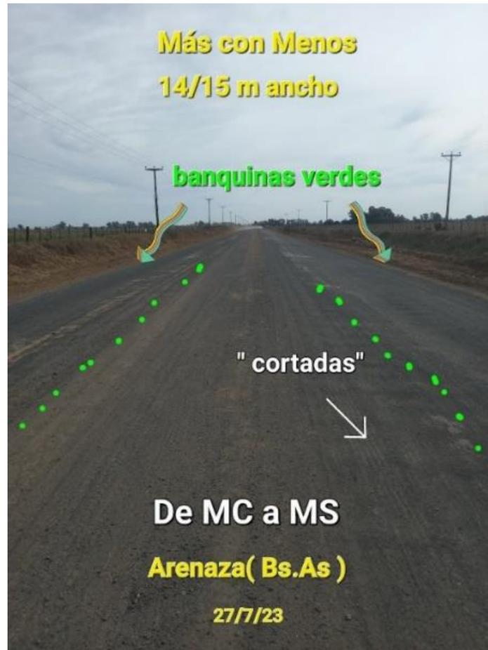
Se estabilizó la zona (14/15 m), directamente esparciendo materiales sobre el perfil clásico de camino con “las tres vías” del MC, generado por el paso de las hojas niveladoras por los laterales (en un principio quedan más “lisos”, por eso se transita por los dos costados) y el centro de la calzada (por donde debiera circular), con irregularidades, acorde con la cantidad y tipo de suelo desplazado, en muchos casos con restos vegetales sin compactar o, a lo sumo, efectuado inadecuadamente.
