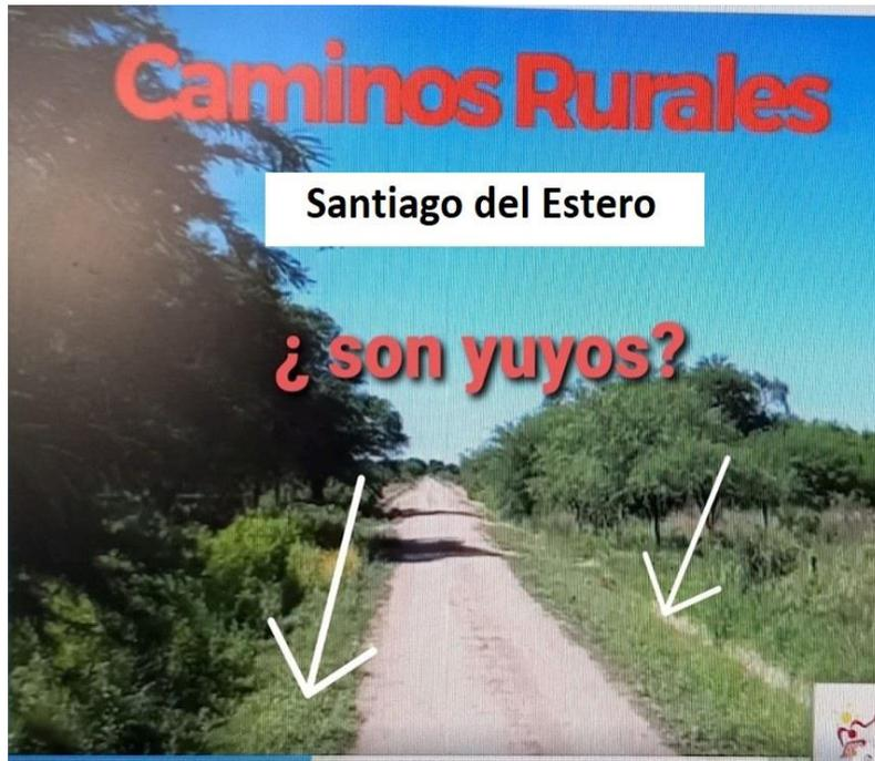
Nada hemos logrado. Una vez más encontramos signos de erosiones laminares y por surcos, con cunetas en V, lo que aumenta la velocidad y poder erosivo de las aguas excedentes.
