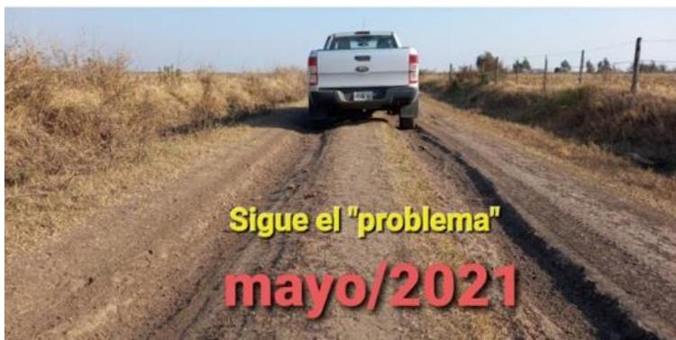
Recurrentemente desde hace décadas, removemos de cuneta a cuneta como se aprecia en la imagen siguiente (05/2017), con “los puntos rojos” como “duros” indicadores de **degradación**, que el MC denomina **mantenimiento**.
