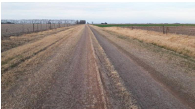
La imagen inferior (foto 147) muestra que con pocos materiales en las huellas, no remociones y pasto logramos razonablemente transitabilidad con mayor seguridad vial.
