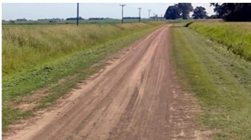
160. Ancho de calzada determinado por la intensidad del tránsito, que determina hasta dónde permite que avance el pasto de las banquinas.
