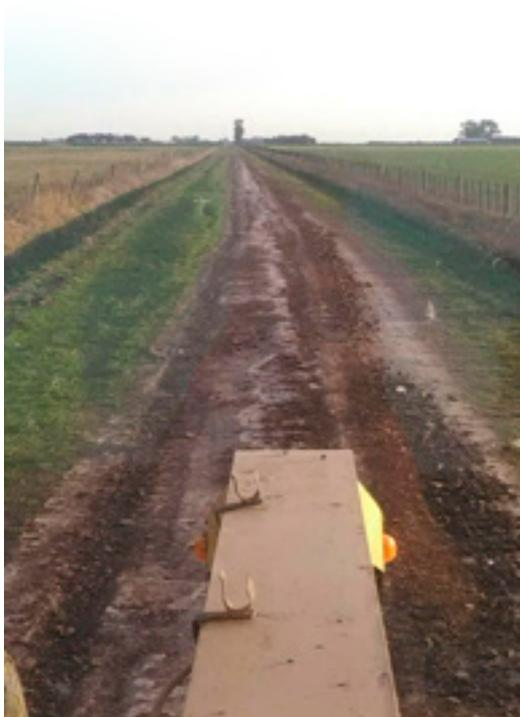
173. Leve borrado de huellas con motoniveladora, conservando el bioasfalto de las banquetas.
